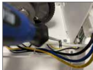
2. Lossa skruvarna som håller fast kabeln.
